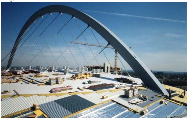
Abbildung 2. Dach der KölnArena während des Baus (Copyright: Philipp Holzmann AG)
